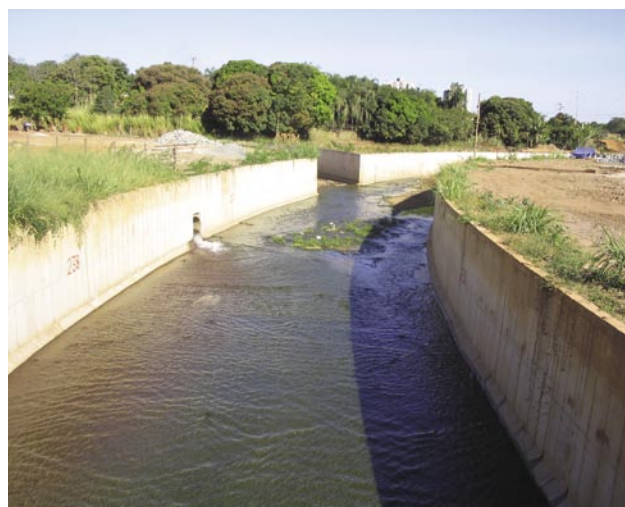
Na obra do Córrego Cascavel, foram utilizados 8 mil m 3 de concreto (Fck 20 MPa e 25 MPa), Brita 0/1, Slump 10+/-2 cm com 8% de Sílica Ativa
