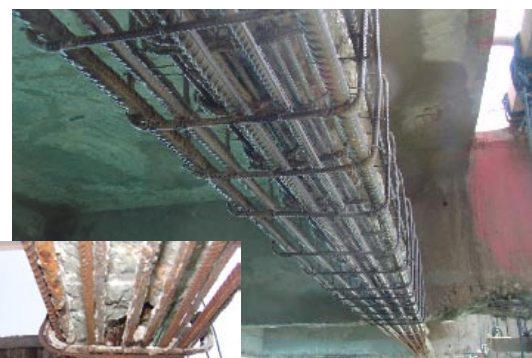
Armadura antes e após o hidrojateamento com areia
