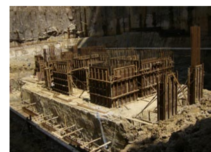
Fundação: blocos de grandes dimensões
