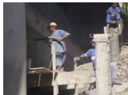
Aplicação do concreto projetado com sílica ativa Silmix
