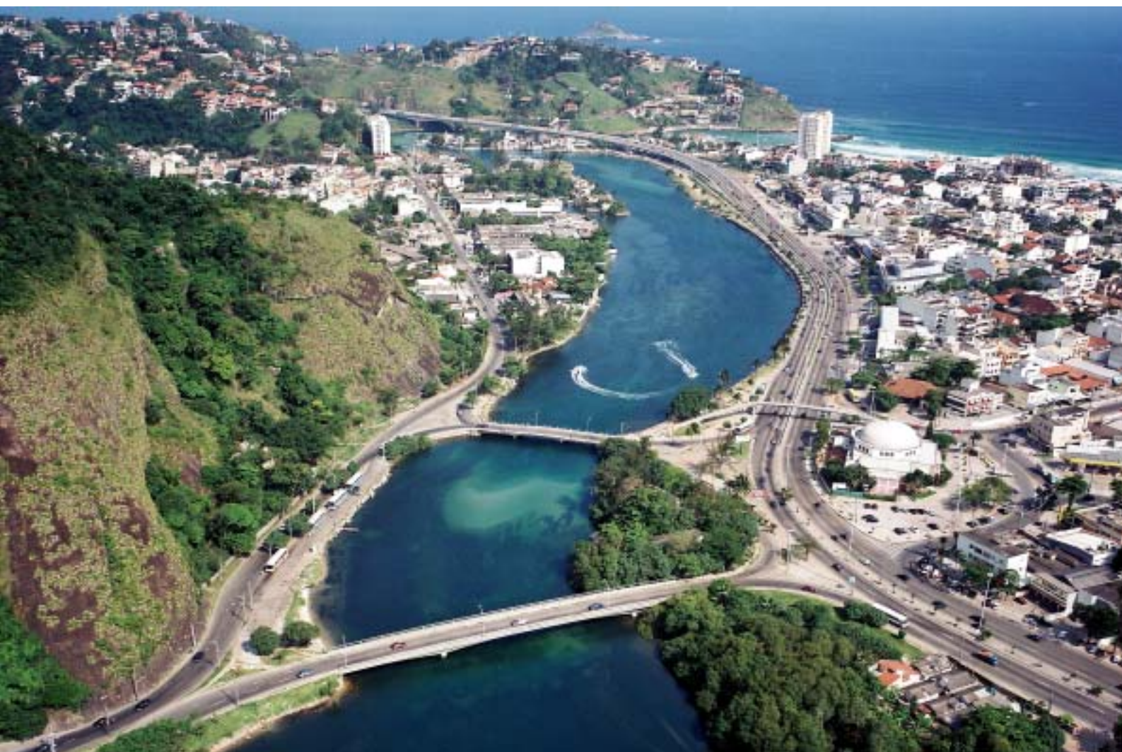
As estruturas da Ponte Nova da Barra foram recuperadas sem interrupção do trânsito
