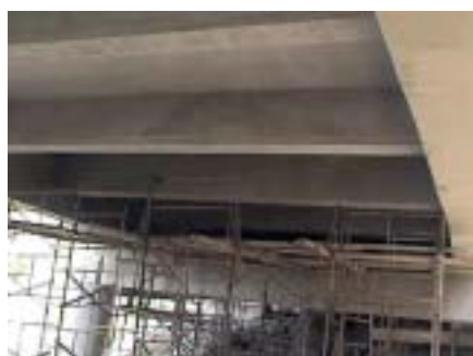
Transversinas concretadas e com acabamento superficial
