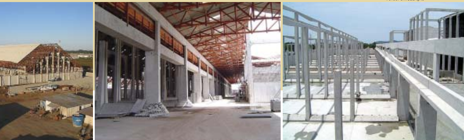
A madeira fica restrita à estrutura da cobertura
