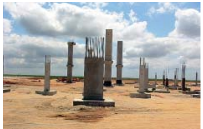
Estrutura de pré-moldados foi fabricada no local
