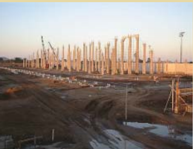
A estrutura de concreto resiste à agressividade dos fertilizantes
