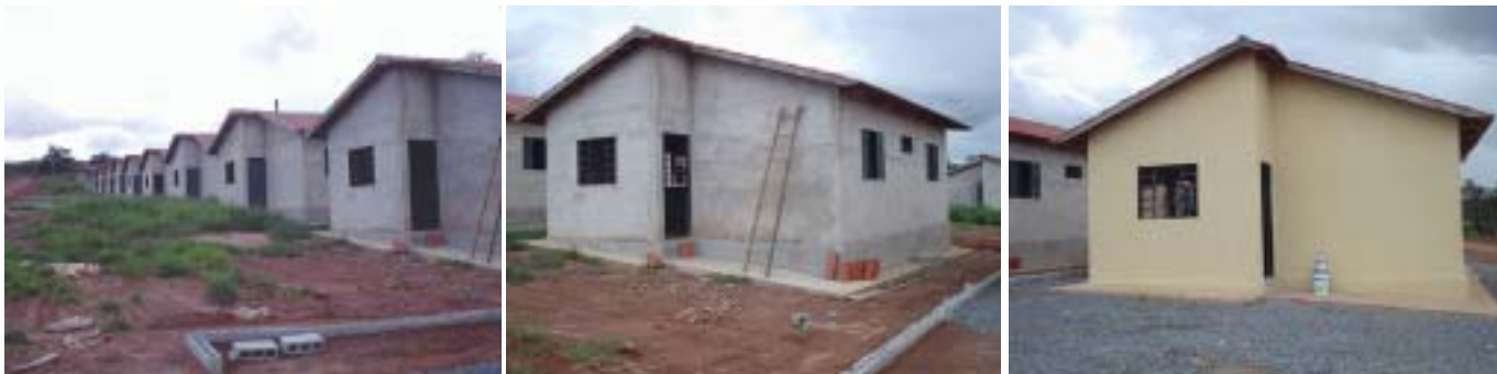
A argamassa é usada no rejunte e no revestimento dos blocos – as paredes ficam prontas para receber pintura
