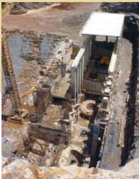
Casa de força
