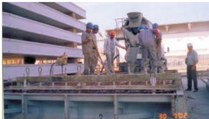
Terminal da Copersucar em Santos (SP): lançamento de concreto nas formas
