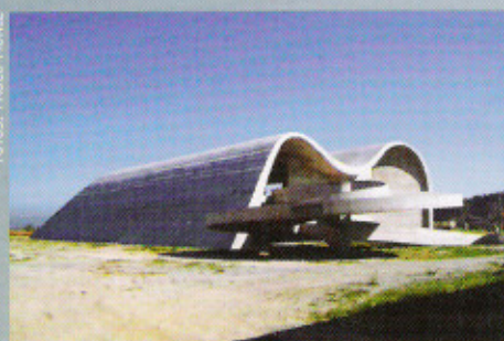
Teatro Popular: um dos edifícios em construção
