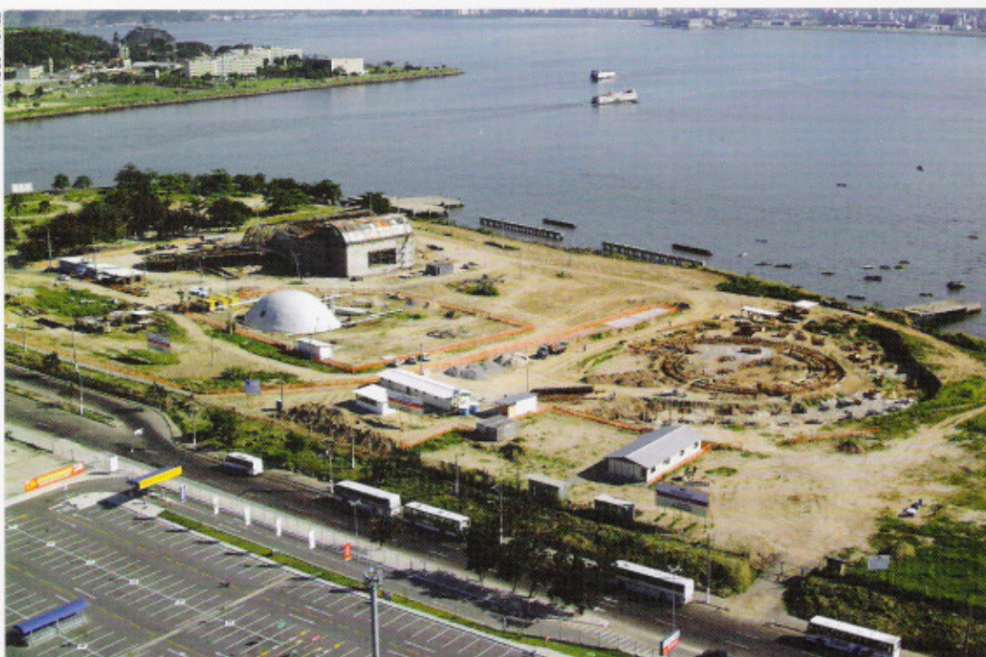
Conjunto arquitetônico (na foto, em fase inicial) fará parte da paisagem da Baía de Guanabara
